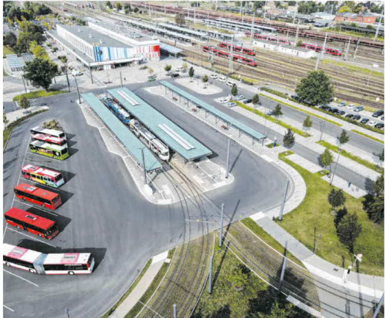
Der Cottbuser Bahnhof ist nach seinem Umbau zum Verkehrsknoten preisgekrönt. Nun sollte auch der alte Bahnknoten ausgebaut werden. Foto: Michael Helbig
